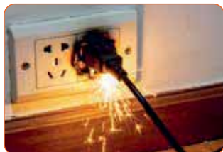
● 插头与插座松动, 接触不良, 局部过热产生火花引发火灾
