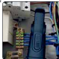
● AFDD, Data logging, 可以长时间在线路中监测异常‘电弧’发生并记录储存 (仅限MS-BAFDD1)
