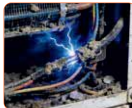
● 电器污积散热通风空间不够, 或者故障长时间高用电量导致发热引起火灾隐患
